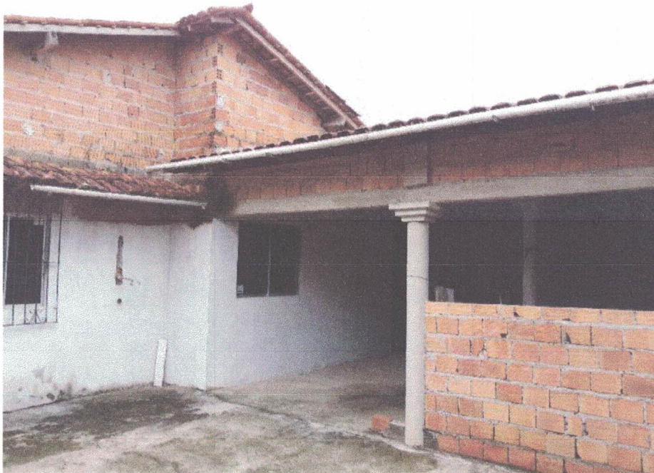
Foto 40: Área livre, fundos da edificação.
