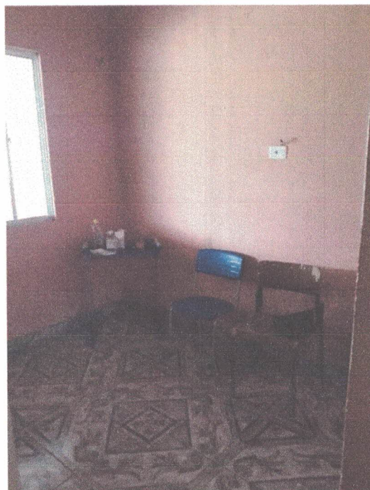
Foto 09: Sala do Corpo Técnico, piso em revestimento cerâmico estampado, paredes rebocadas e pintadas na cor salmão, sem emassamento.
