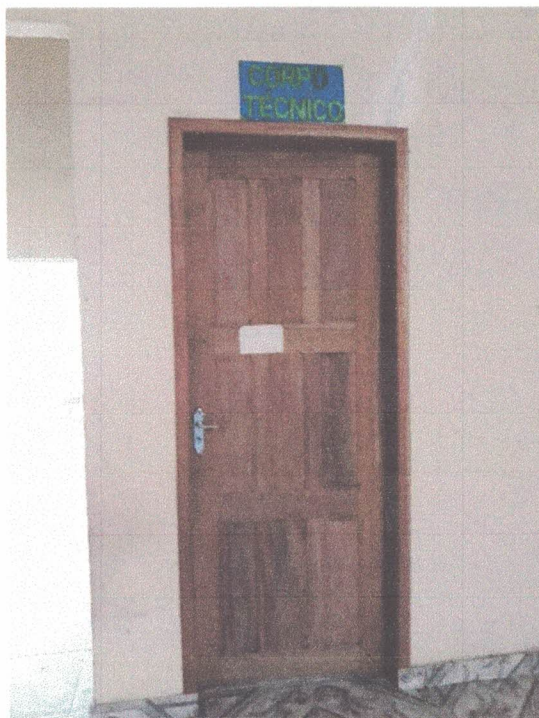
Foto 07: Sala do Corpo Técnico, esquadrias de madeira.
