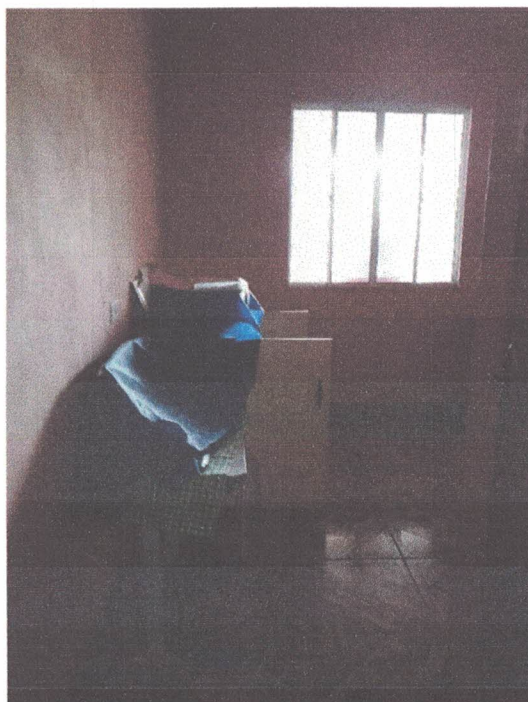
Foto 08: Sala do Corpo Técnico, esquadrias de madeira e alumínio.
