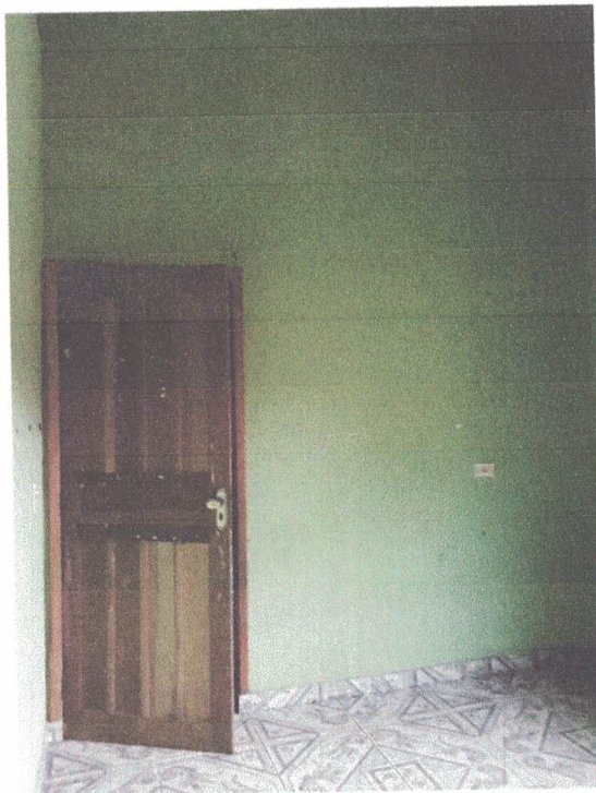
Foto 23: Sala do CAE, paredes rebocadas e pintadas na cor verde, com emassamento.
