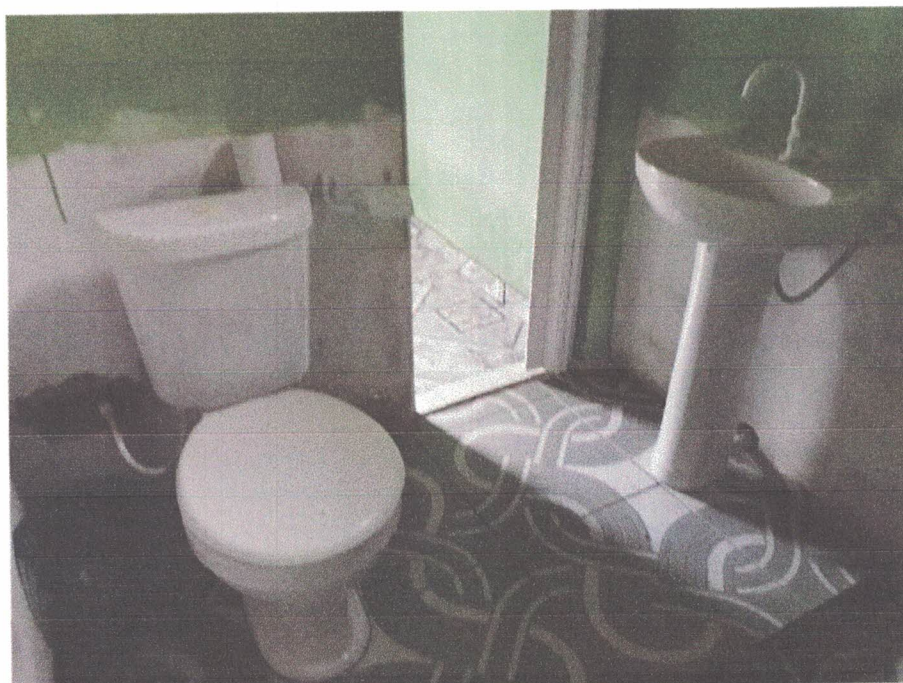
Foto 26: Banheiro da Sala do CAE, piso em revestimento cerâmico estampado.
