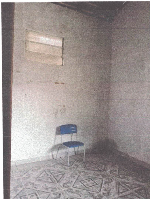
Foto 29: Sala da FUNDEB, piso em revestimento cerâmico estampado, paredes rebocadas e pintadas na cor branca, sem emassamento.
