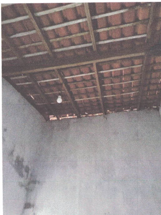
Foto 30: Sala da FUNDEB, cobertura em estrutura de madeira com telha cerâmica tipo capa/canal colonial.
