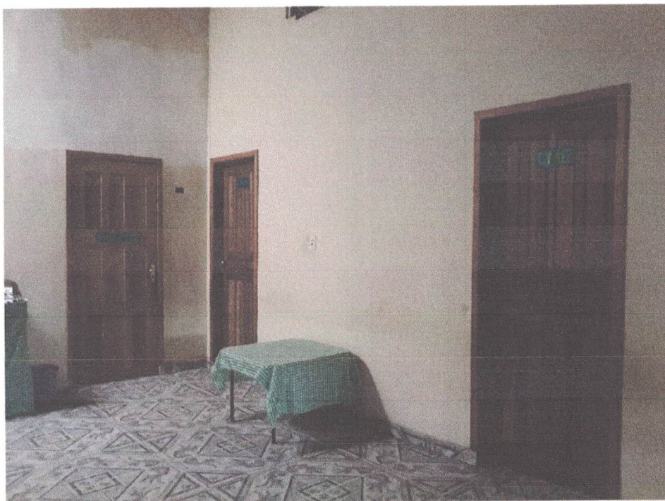
Foto 14: Cozinha, paredes rebocadas e pintadas na cor areia, com emassamento.
