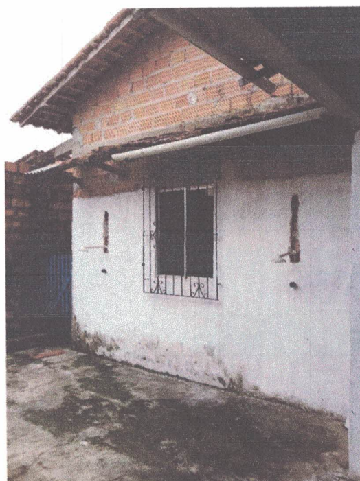
Foto 38: Área de serviço, chuveiros externos.
