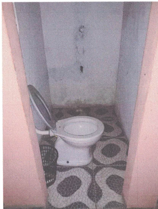
Foto 11: Banheiro da sala do Corpo Técnico, piso em revestimento cerâmico estampado.
