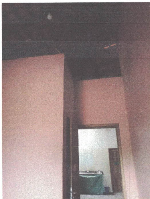
Foto 10: Sala do Corpo Técnico, cobertura em estrutura de madeira com telha cerâmica tipo capa/canal colonial.
