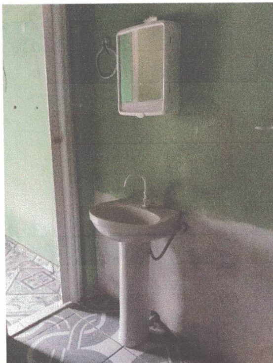
Foto 25: Banheiro da Sala do CAE, paredes rebocadas e pintadas, sem emassamento.
