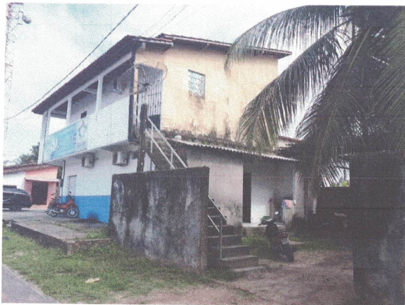
Foto 02: Fachada lateral direita da edificação, acesso à área dos fundos.
