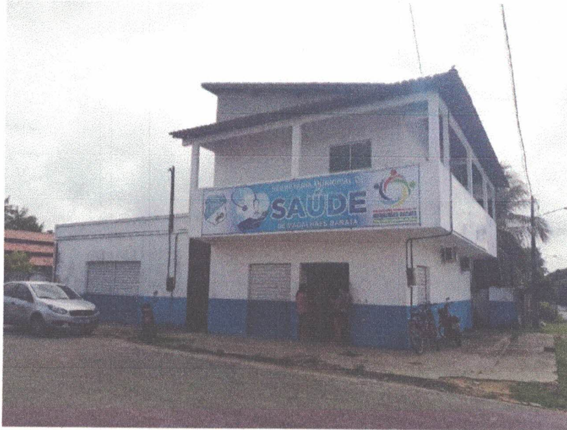
Foto 01: Fachada frontal da edificação principal e anexo.
