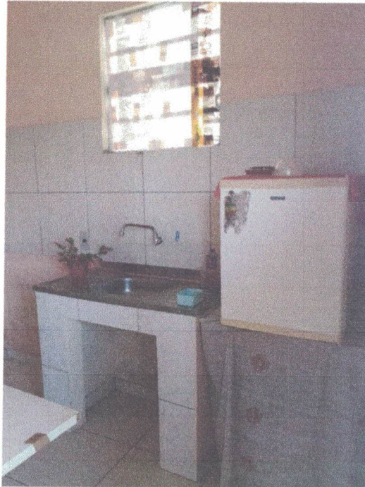
Foto 51: Pavimento superior - Sala 01, parede da cozinha com revestimento cerâmico na cor branca, até 1,80m paredes rebocadas emmassadas e pintadas na cor salmão.
