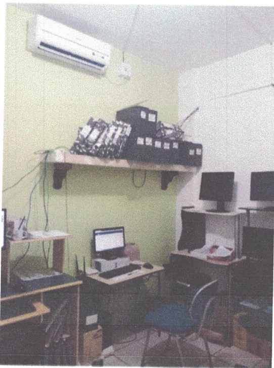
Foto 18: Sala Sistemas/Informática, laje em concreto rebocada e pintada na cor branca.
