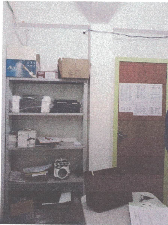
Foto 11: Sala TFD, paredes rebocadas emassadas e pintadas na cor branca.
