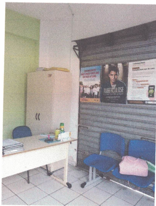
Foto 04: Recepção, piso em cerâmica na cor branca, laje em concreto rebocada e pintada na cor branca.
