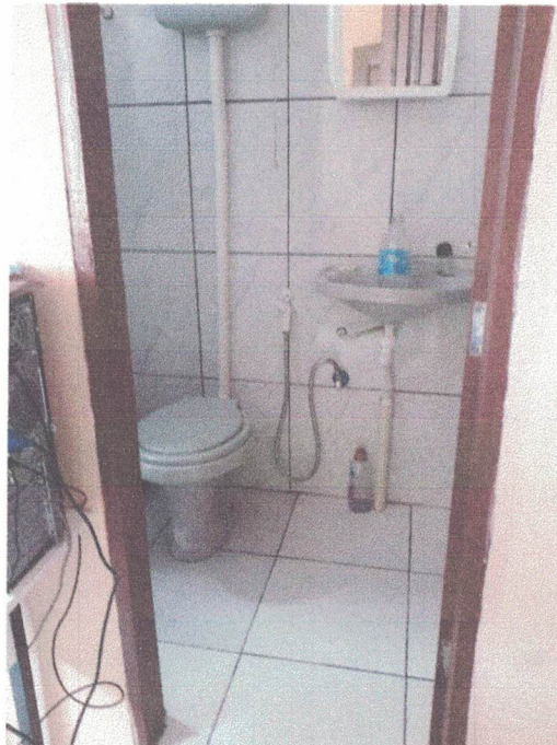
Foto 54: Pavimento superior – banheiro da Sala da Assessoria, piso e paredes com revestimento cerâmico na cor bege.
