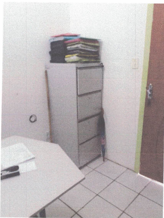
Foto 08: Sala de Regulação, esquadrias de madeira semioca.
