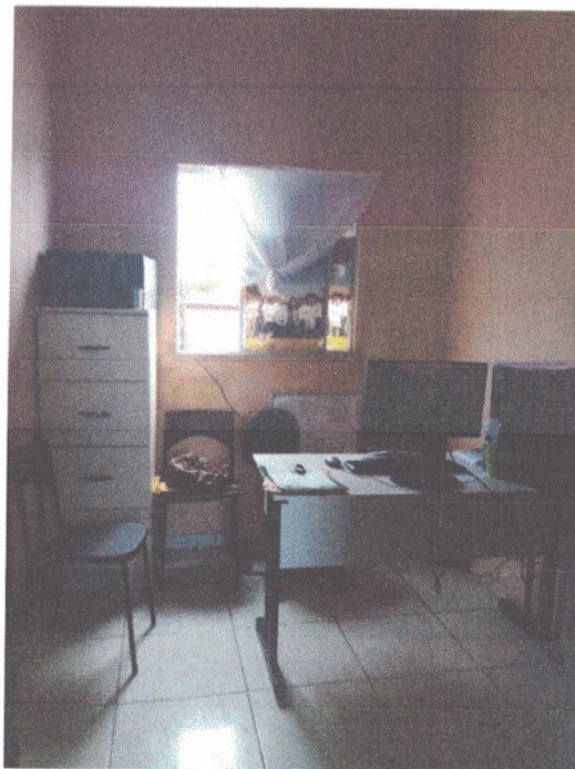
Foto 52: Pavimento superior - Sala da Assessoria, piso cerâmico na cor bege, paredes rebocadas emmassadas e pintadas na cor salmão.
