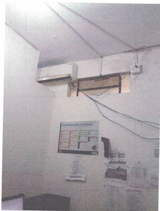
Foto 20: Sala Vigilância de Saúde, paredes rebocadas e pintadas na cor branca.
