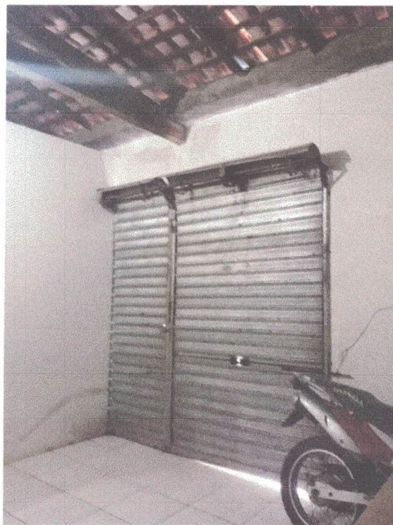
Foto 30: Sala 01, portão de enrolar, paredes rebocadas e pintadas na cor branca e sem forro.
