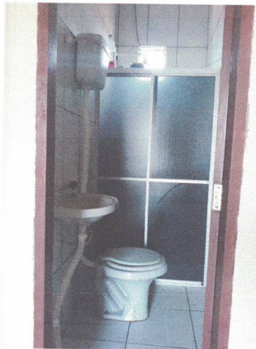
Foto 60: Pavimento superior – banheiro, piso cerâmico na cor bege, paredes rebocadas emassadas e pintadas na cor salmão.
