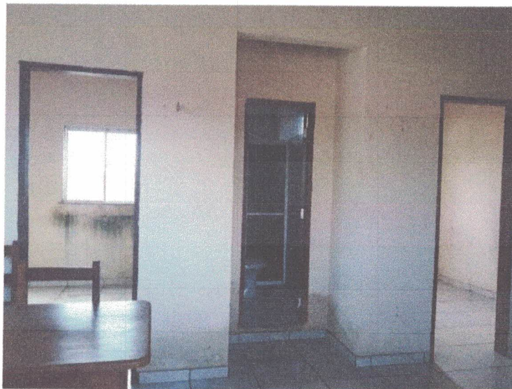
Foto 55: Pavimento superior - Sala 02, piso cerâmico na cor bege, paredes rebocadas emassadas e pintadas na cor salmão, com sinais de umidade ascendente e acúmulo de matéria orgânica na base da janela.
