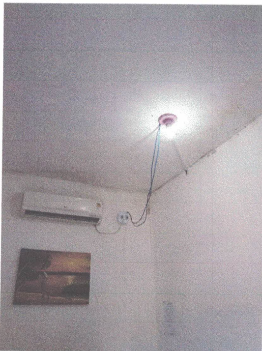
Foto 07: Sala de Regulação, paredes e laje de concreto, rebocadas e pintadas na cor branca.
