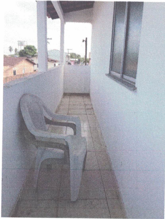
Foto 49: Pavimento superior - circulação, paredes rebocadas emassadas e pintadas na cor branca.
