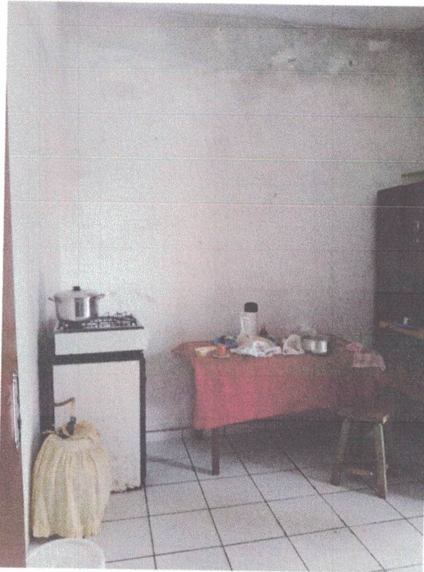
Foto 25: Cozinha, paredes rebocadas e pintadas na cor branca.
