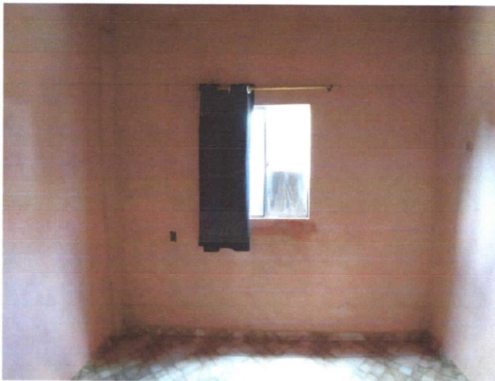
**Foto 11:** Quarto 01, detalhe para esquadria de alumínio com duas folhas de vidro, uma fixa e outra móvel.
