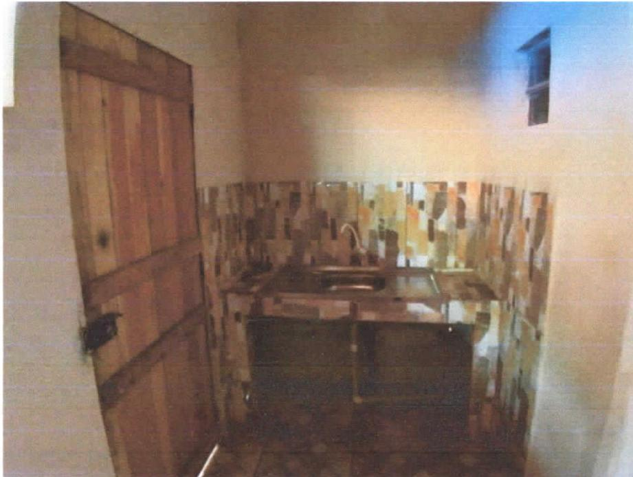
**Foto 19:** Cozinha, detalhe para pia em inox sobre base em alvenaria com revestimento cerâmico.
