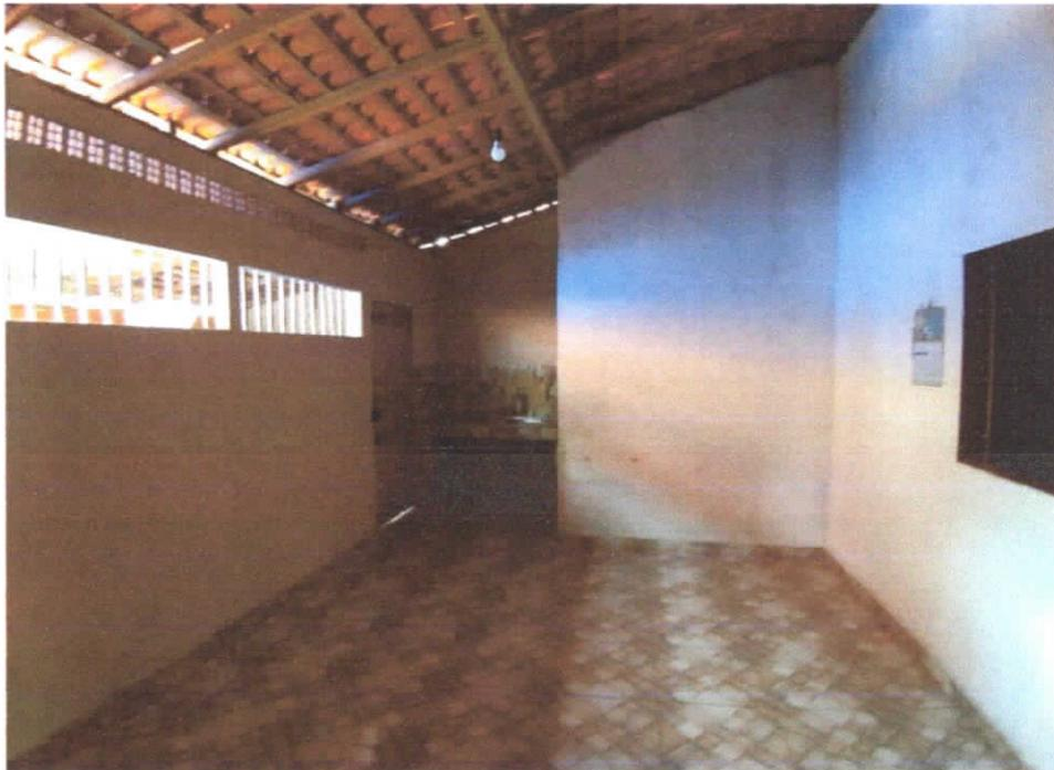
**Foto 17:** Cozinha, paredes pintadas e rebocadas na cor branca, sem emassamento, detalhe para o gradil em metalon.
