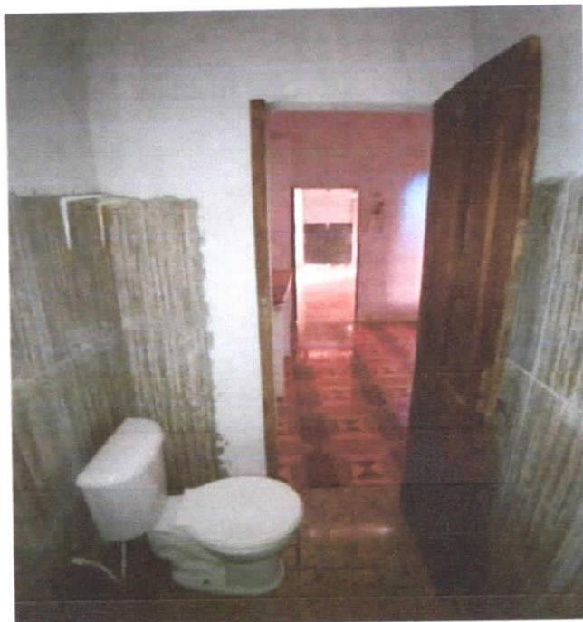
**Foto 29:** Banheiro 02, paredes com revestimento cerâmico até 1,80m de altura .
