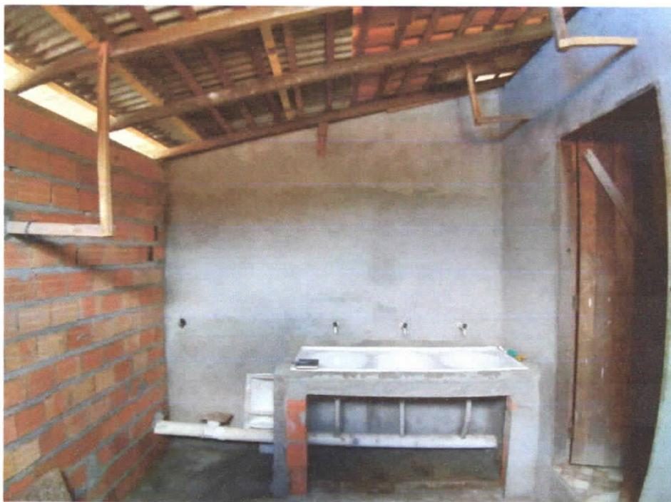
**Foto 23:** Área de serviço, detalhe para tanque em fibra com três cubras e torneiras de parede em plástico.
