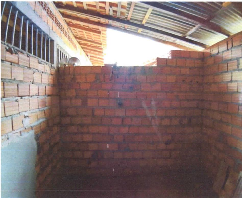
**Foto 22:** Área de serviço, detalhe para piso sem revestimento e parede duas fiadas mais baixas.
