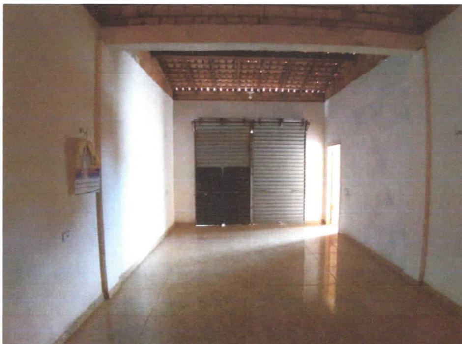
**Foto 32:** Garagem, detalhe para ausência de forro e portas metálicas de enrolar.
