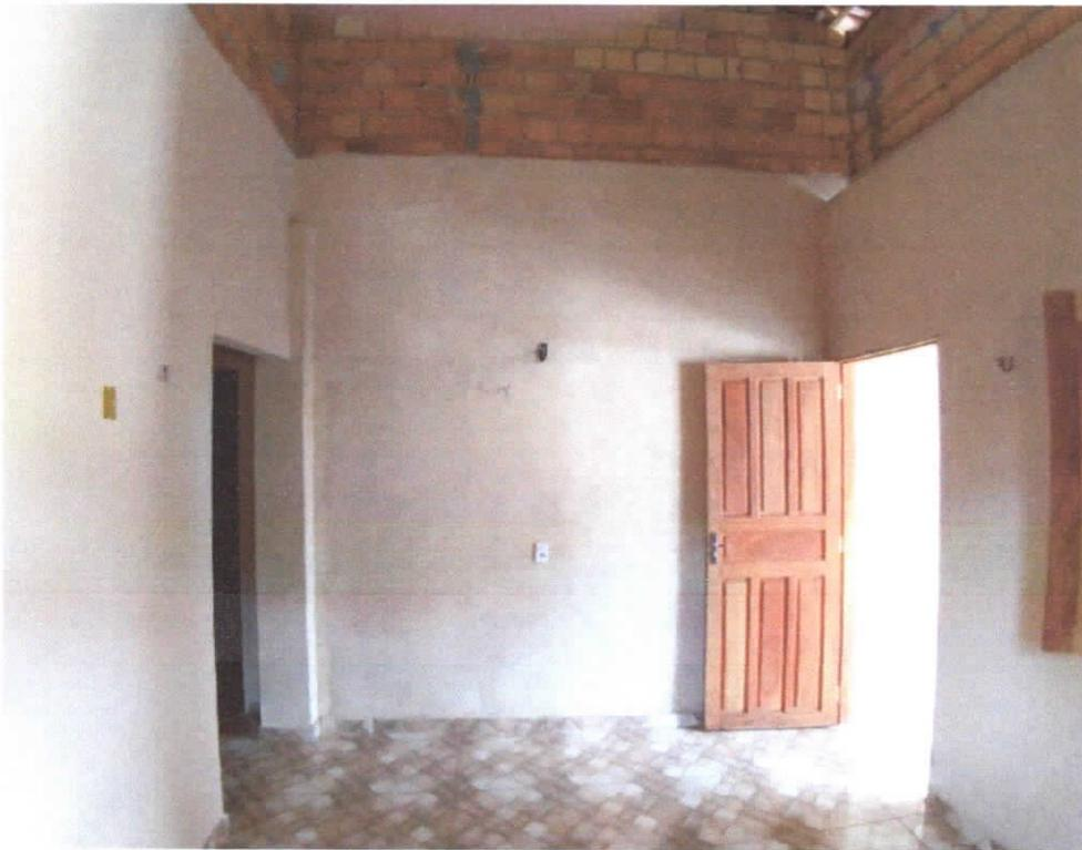
**Foto 07:** Sala 01, paredes rebocadas e pintadas na cor rosa pastel com piso cerâmico 40x40cm.
