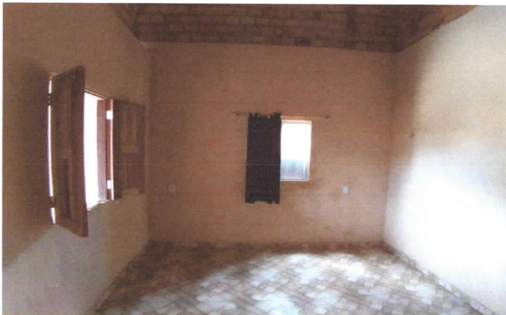
**Foto 06:** Sala 01, paredes rebocadas e pintadas na cor rosa pastel, esquadria de alumínio e vidro.
