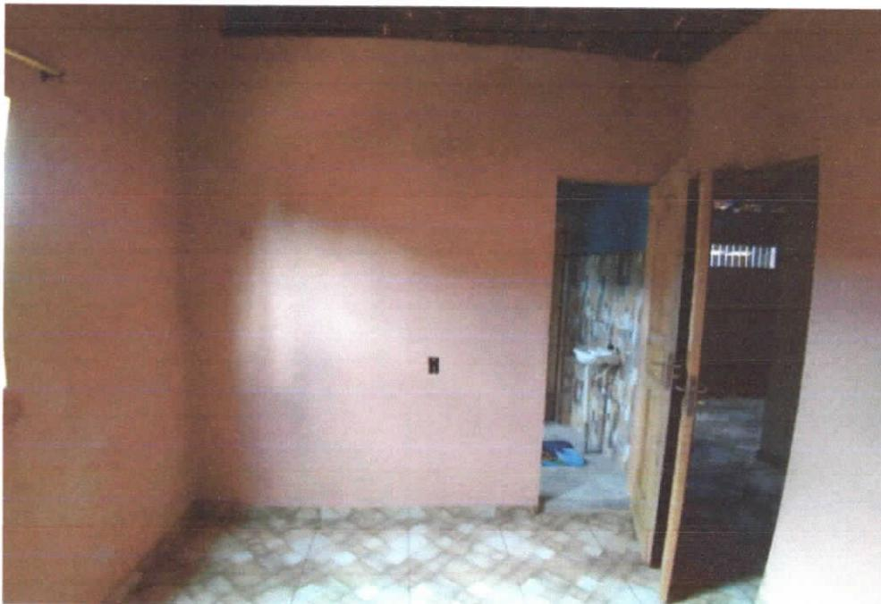
**Foto 10:** Quarto 01, detalhe para ausência de forro e finalização em ponto elétrico.
