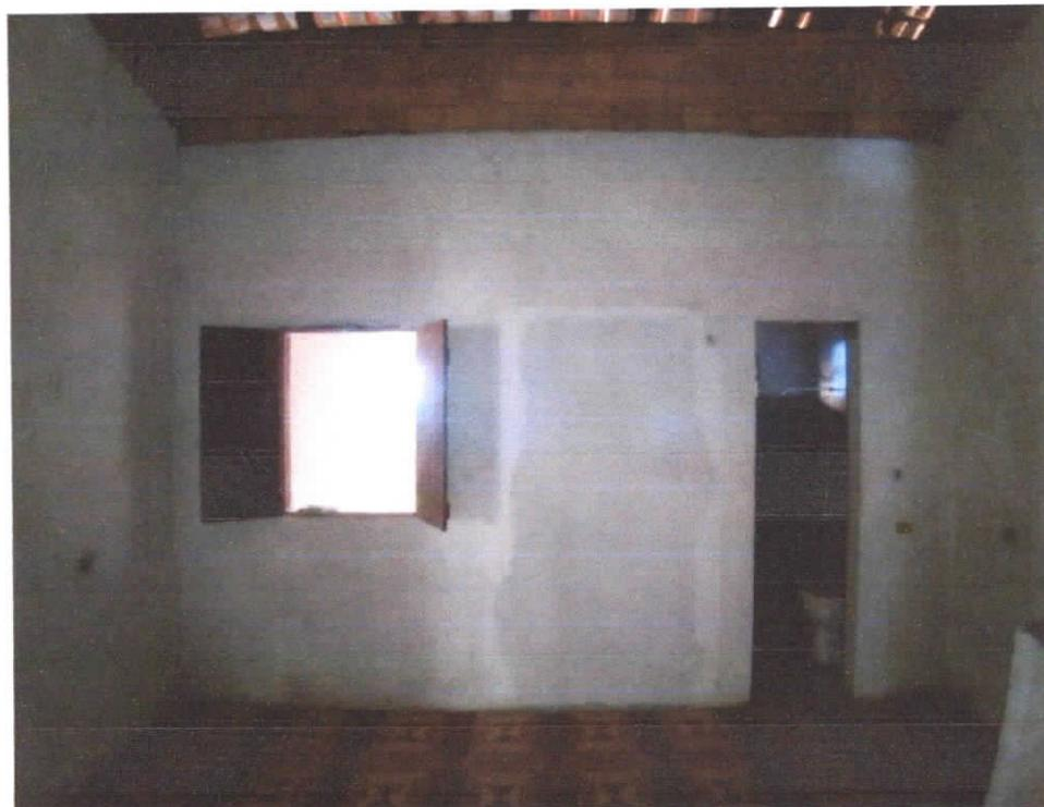
**Foto 25:** Sala 02, paredes rebocadas e pintadas na cor branca, sem emassamento.
