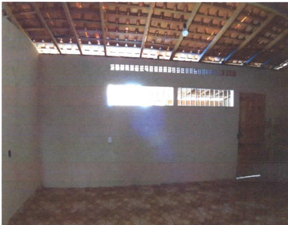
**Foto 20:** Cozinha, detalhe do gradil e ausência de forro.
