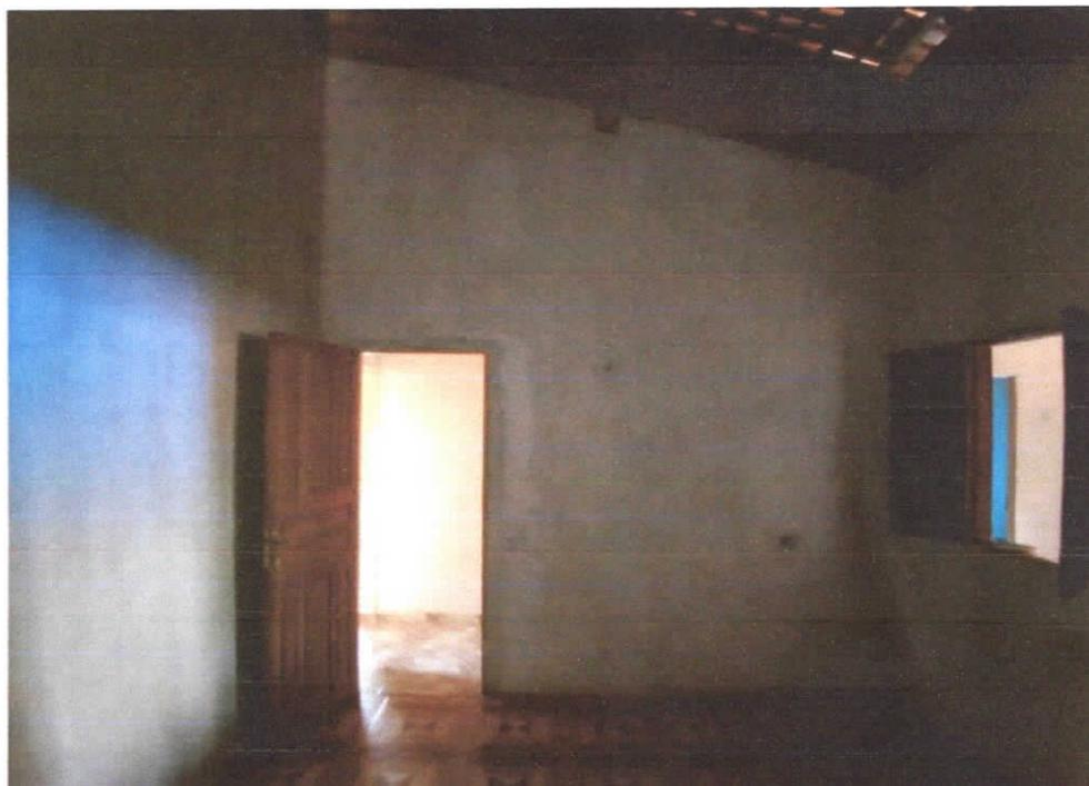
**Foto 26:** Sala 02, piso com revestimento cerâmico 40x40cm, detalhe para ausência de forro.
