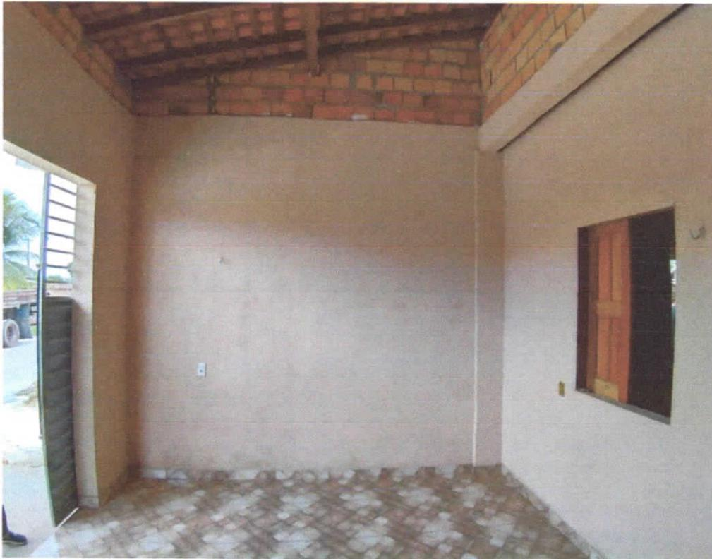
**Foto 05:** Recepção/Pátio, detalhe para ausência de forro.
