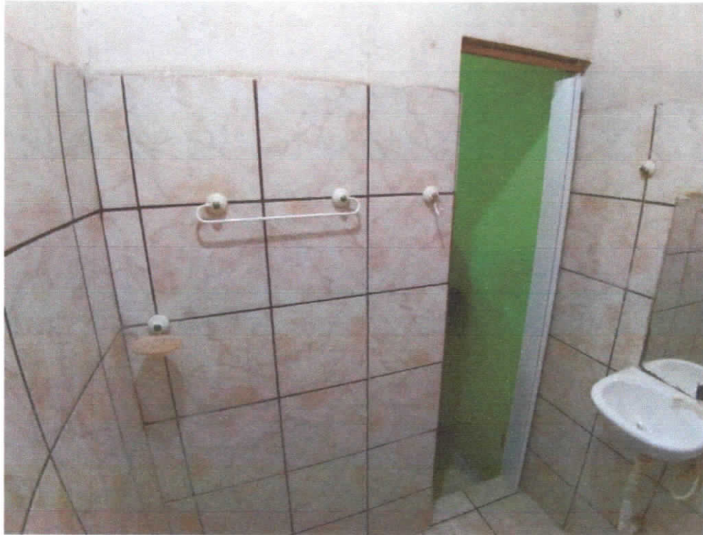
Foto 09: Banheiro, detalhes a louças e porta sanfona.
